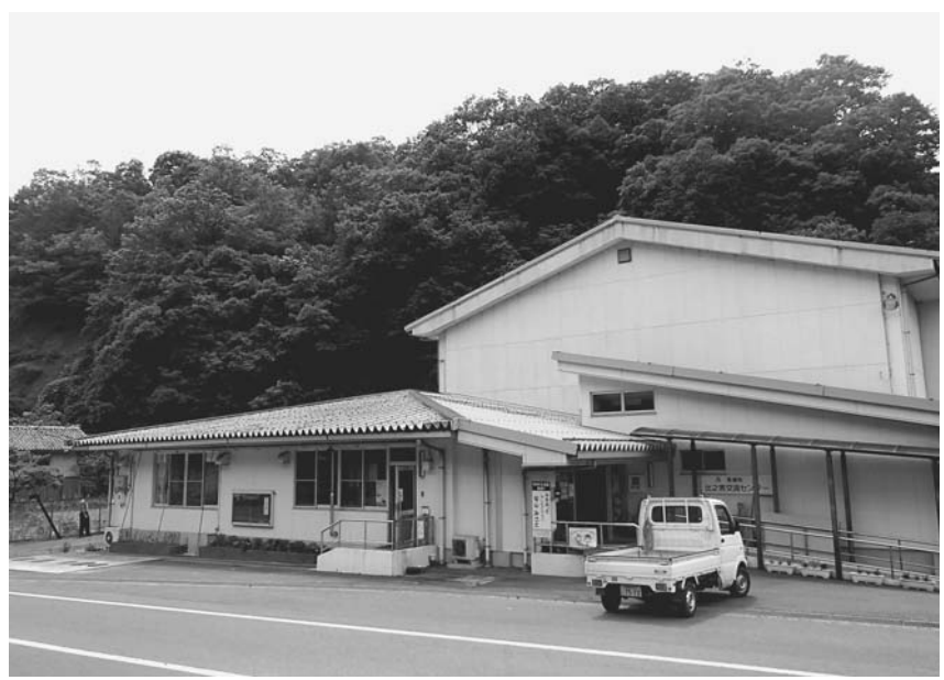
屋根の塗装が必要な比之宮交流センター
