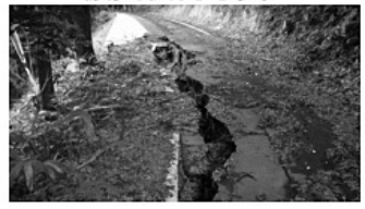
被災状況写真
